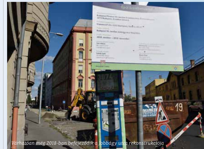
Modernizálták a Dobsuli fűtési rendszerét is
